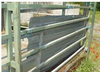
FIGURA 13 – A usual utilização de chapas metálicas significa, normalmente, a incorporação de mais uma fonte de perigo.
