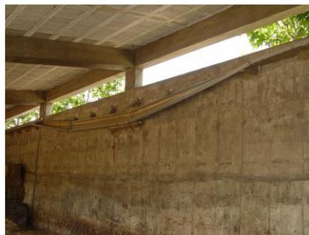
FIGURA 11 – Sistema de iluminação sujo e em condições deficiente.
