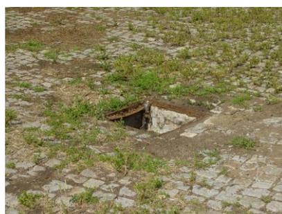
FIGURA 21 – Ausência de tampa de saneamento.
