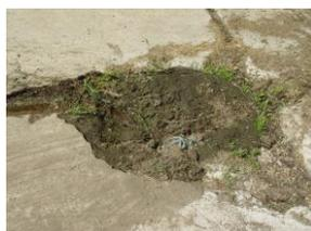
FIGURA 9 – Sistema de drenagem de águas degradado e entupido.
